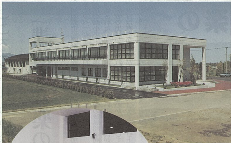
体育センター外観
