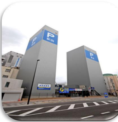
機械式駐車場（タワー式）
